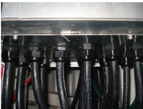
Рисунок 3.25: Пример правильной установки платы уплотнений.
